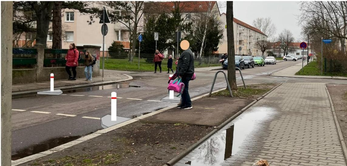
Abb. 54 Hervorhebung der Querungsstelle durch provisorische Bordelemente
