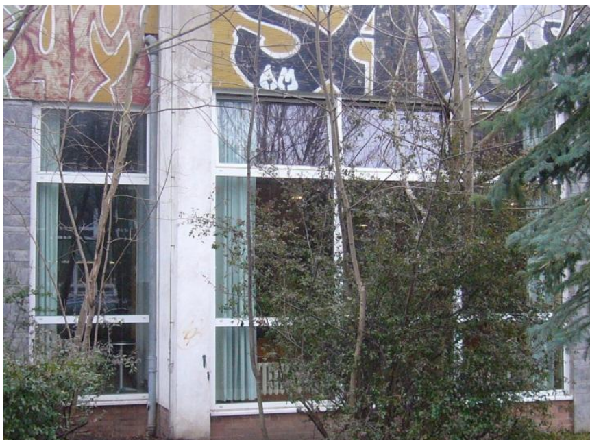
Foto A9, Fenster Grünflächenamt, Gebäude 1, Planungsbüro Wahlbuhl 2012
