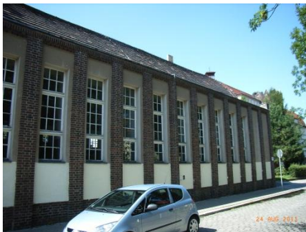
Foto A17, Turnhalle der Grundschule Albrecht Dürer, Planungsbüro Wahlbuhl 2012
